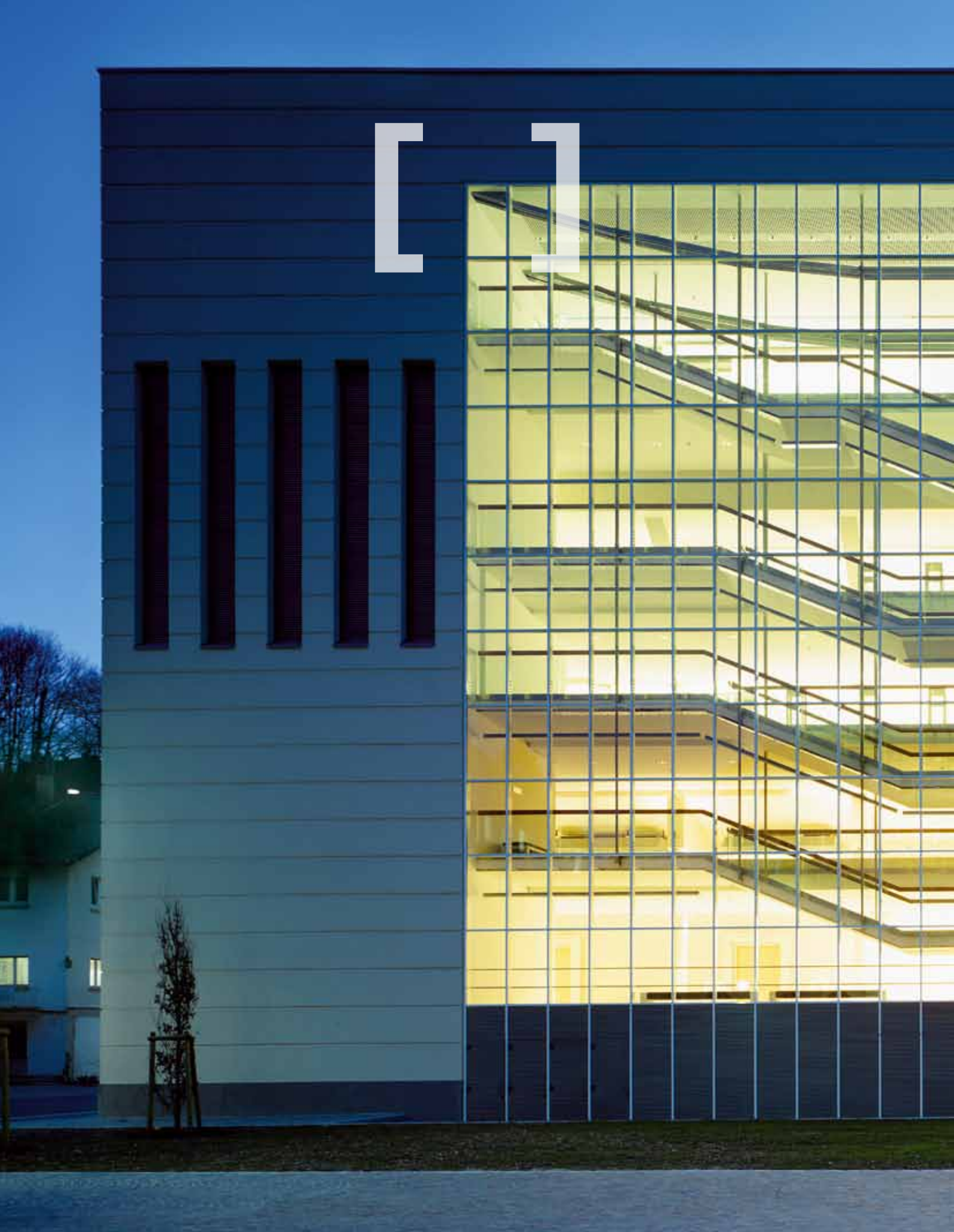
[ Objekt Festspielhaus Baden-Baden | Bauzeit 1996–1998 | Auftragsumfang gesamte Tragwerksplanung | Architekt Prof. Wilhelm Holzbauer, Wien ]
